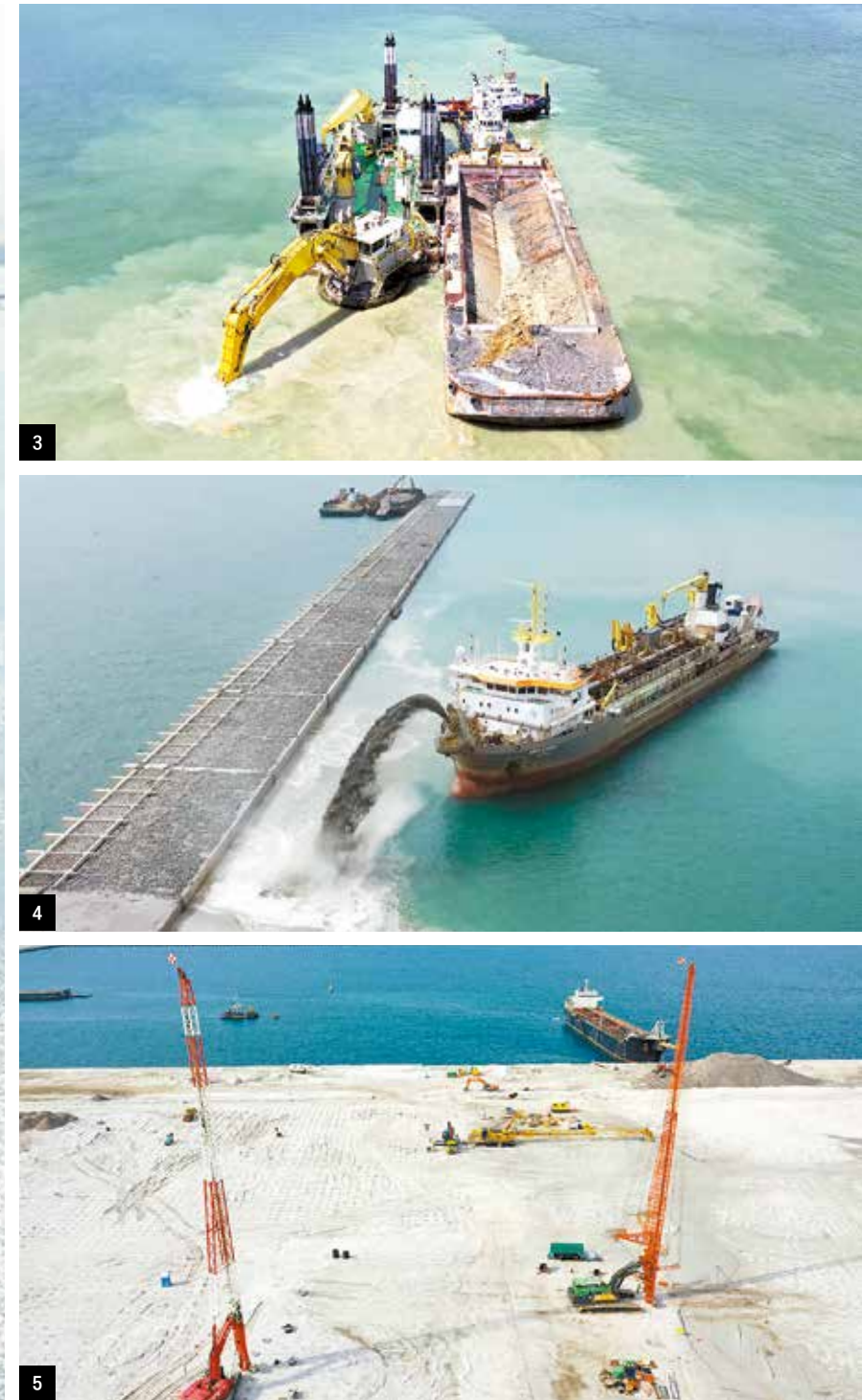
1 싱가포르 투아스 핑거3 매립공사 현장 전경. 2 지난 4월 25일 현장은 케이스 227함 제작 완료 기념 행사를 개최했다. 3 BD(Backhoe Dredger)백호 준설선을 이용한 준설(해저면의 토사, 암석을 굴착하는) 공사. 4 TSHD(Trailing Suction Hopper Dredger)자랑, 준설, 운반, 매립 가능한 다목적 준설선)를 이용한 매립공사. 5 지난 개항을 위한 PVD(Prefabricated Vertical Drain)인양토 저반을 압축 처리하는 가성 연직배수기 운영.
