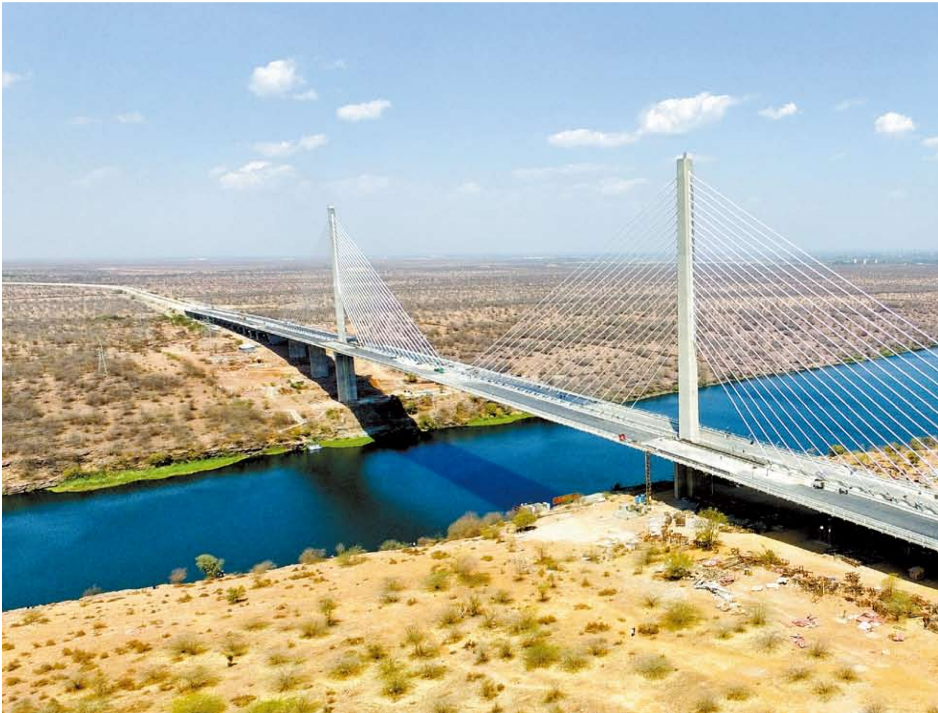
1 2015년 11월 당시 현장 모습. 공사 재개 후 지금까지 무재해를 기록 중이다. 2 P4 지점의 메인 스판 시공 모습. 3 공정률 93%로 순항 중인 현장 전경. 4 날렵한 케이블과 주탑이 교량 상판을 지지하고 있다.
