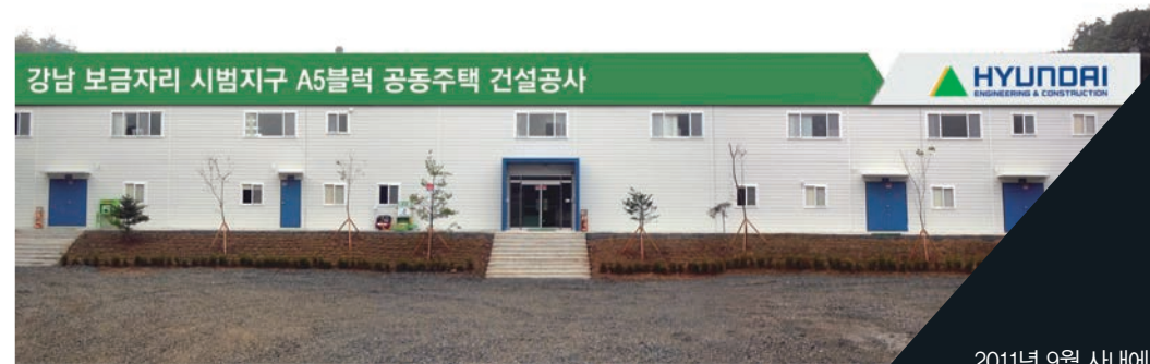
건설 현장 적용 사례
