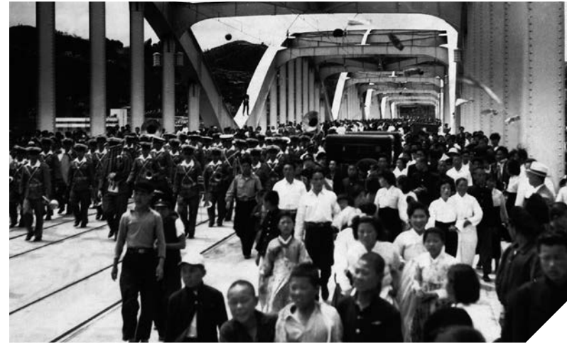
한강인도교(現 한강대교) 복구공사 완공 당시 모습
