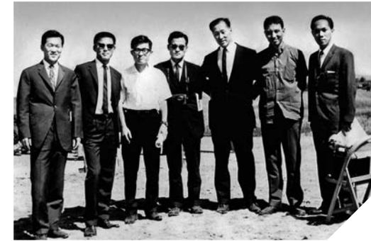
태국 파타나나라티왓 고속도로 공사 현장
