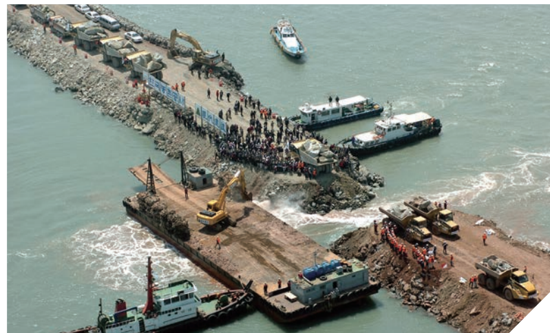
새만금간척사업 최종 물막이공사
