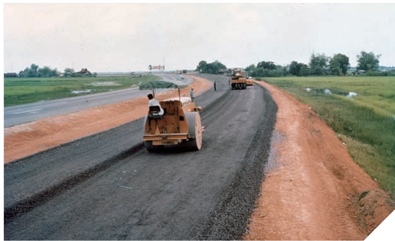
태국 파타나리타왓 고속도로 공사 현장
