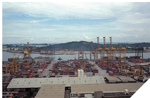
싱가포르 브리니섬 컨테이너 터미널 공사 전경
